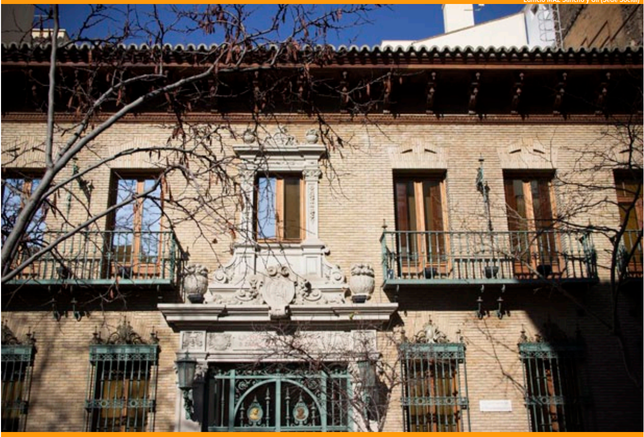
Edificio MAZ Sancho y Gil (Sede Social)
